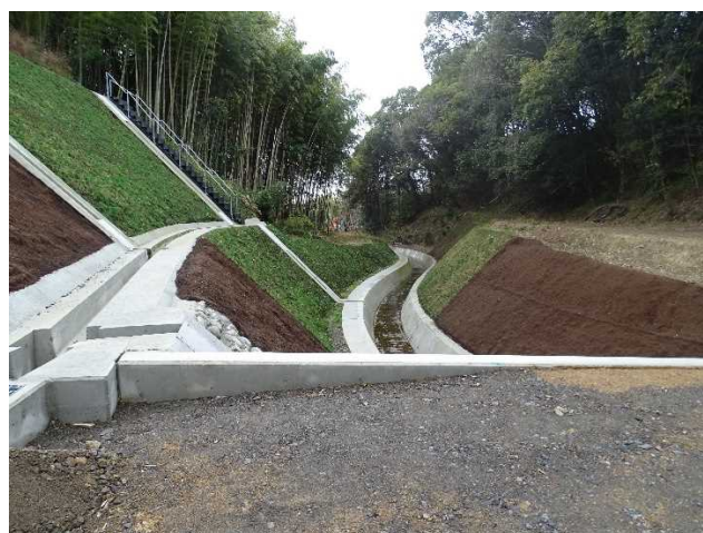
令和7年3月時点 水路工の施工は完成しました。
