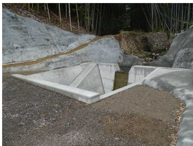
令和7年3月時点 床固工の施工は完成しました。
