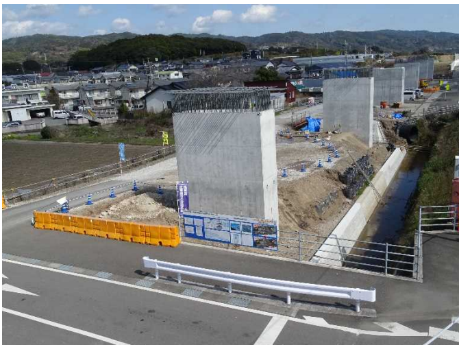
芸西高架橋下部工の施工を進めています。
