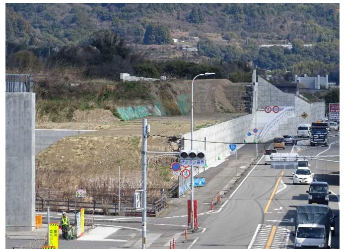
土を盛る工事を進めています。
