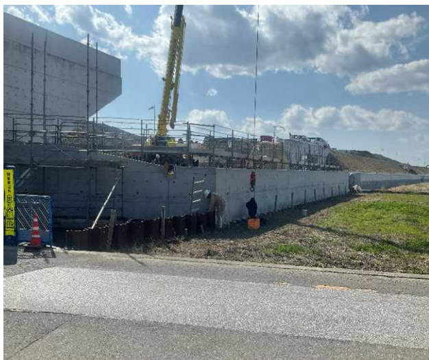
擁壁の施工を行っています。
