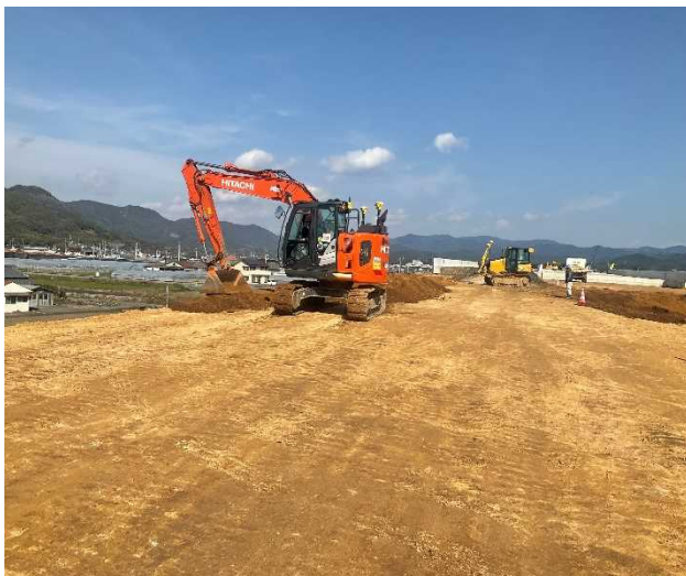
土を盛る工事を進めています。
