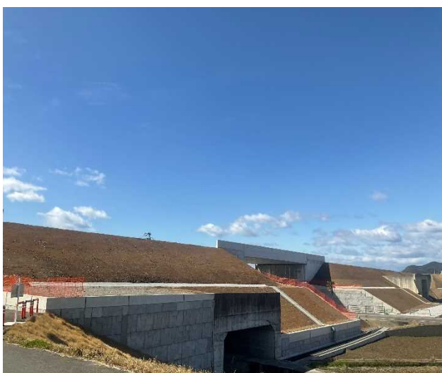
土を盛る工事が完了しました。
