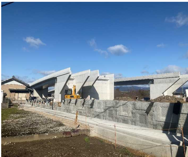
擁壁の施工を行っています。
