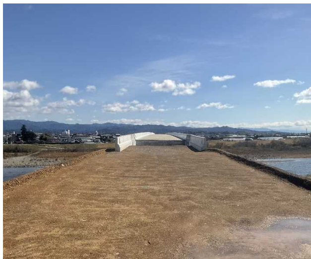
物部川橋前の状況です。
