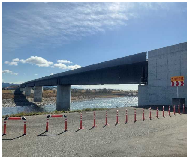
物部川橋の全景です。
