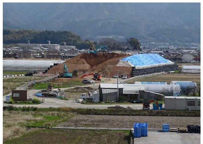
伊尾木方面へ向けて土を盛る工事を進めています。
