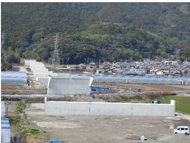
橋脚と函渠の工事を進めています。
