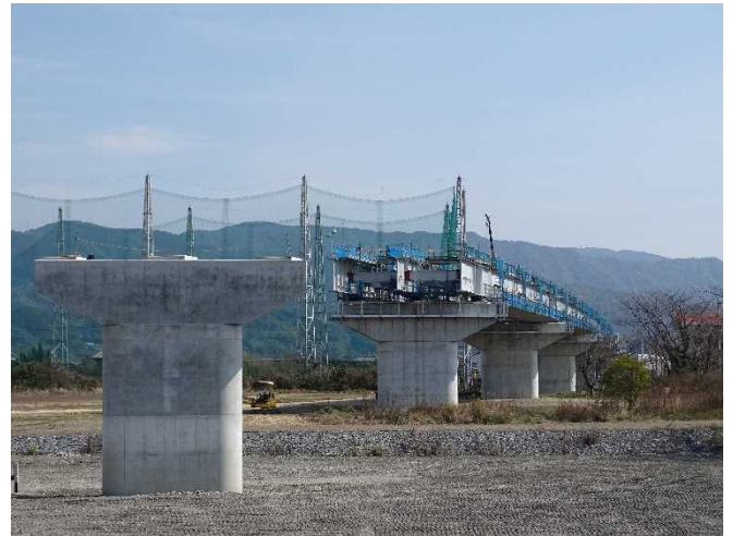
安芸市東浜（撮影方向：東向き）
