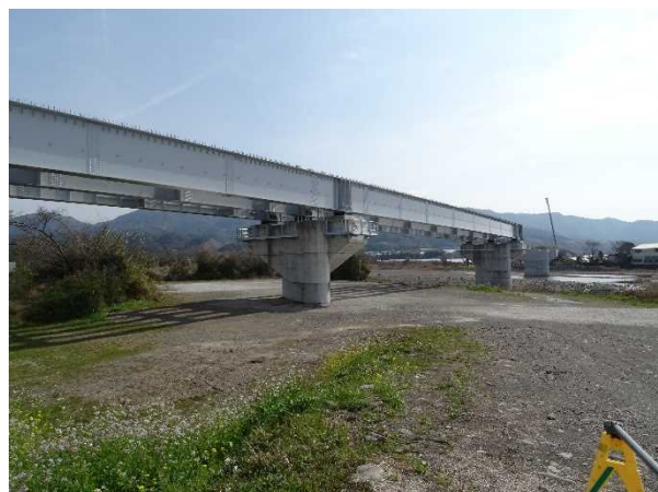
伊尾木川橋 上部工の施工を進めています。
