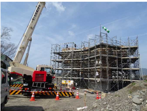
伊尾木川橋 下部工の施工を進めています。
