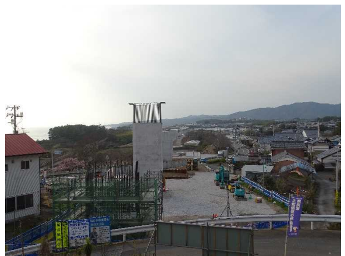
赤野高架橋下部工事を進めています。
