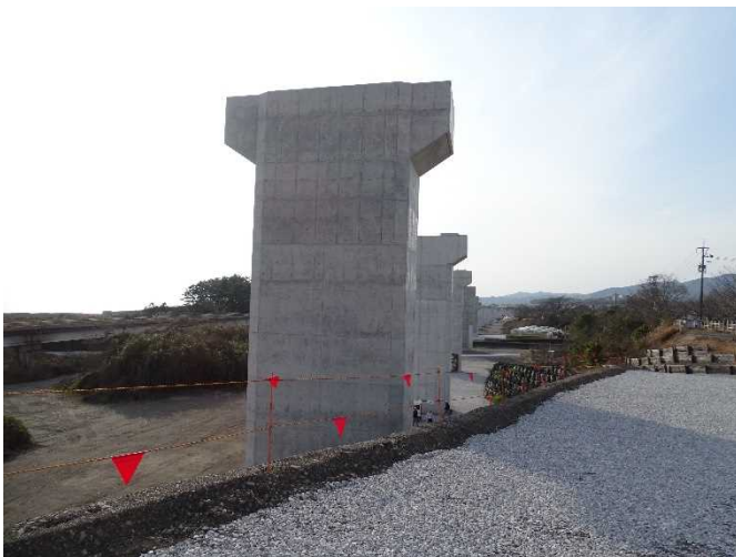
赤野高架橋下部工1基が完成しました。
