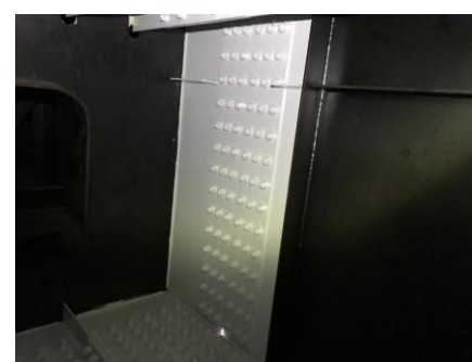
当て板補修工 (完了)
