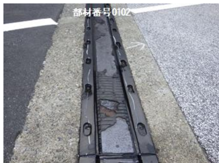
伸縮装置の変形・欠損 (着手前)
