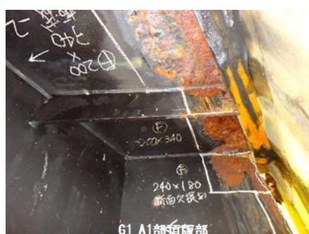
箱桁内部の漏水・帯水による腐食
