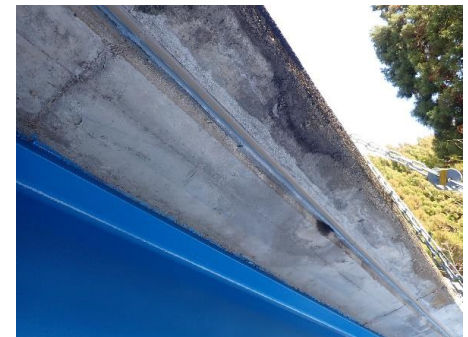
断面修復 (完了)
