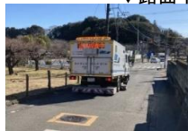
（空洞探査車による調査）
