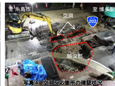
写真④ 空洞反応箇所の確認状況
