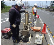
(貫入試験による調査)
