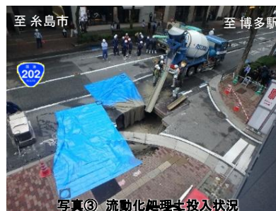
写真③ 流動化処理土投入状況
