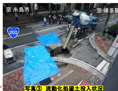
写真③ 流動化処理土投入状況
