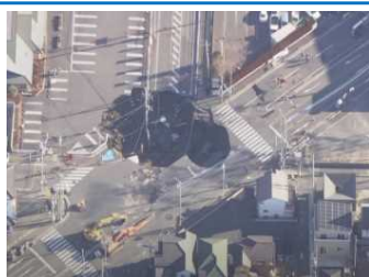
1月31日時点の事故現場の状況
