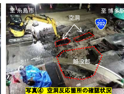
写真④ 空洞反応箇所の確認状況
