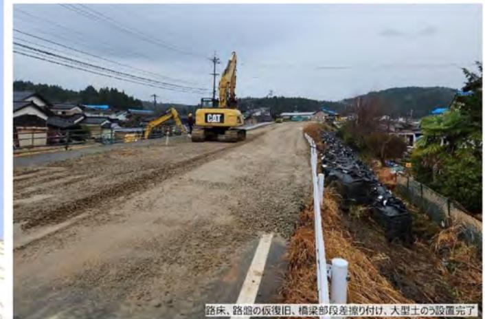
路床、路盤の板復旧、橋梁部段差撤り付け、大型土のう設置完了
