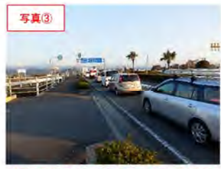
右折車の青時間が不足するため滞留し、速度低下している。
