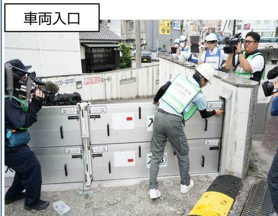
止水板を正常に設置出来るかの確認
