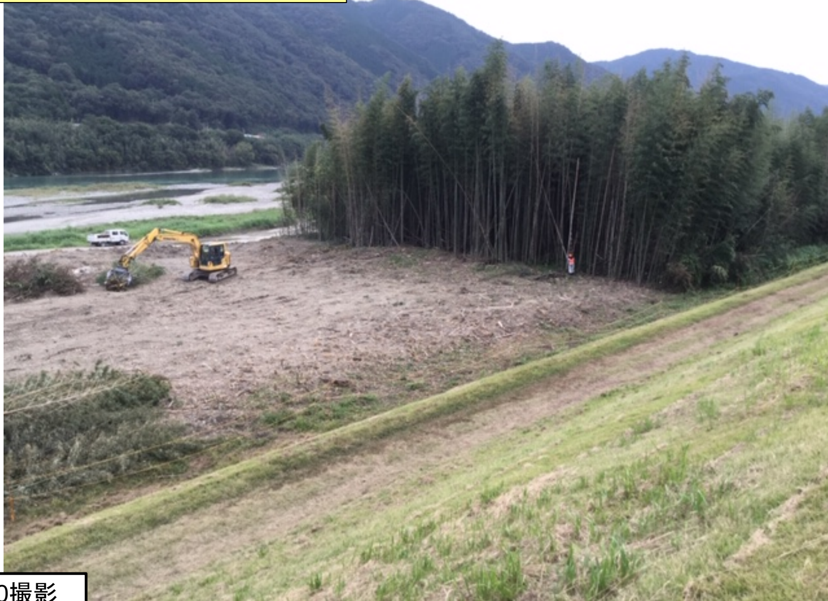
樹木伐採 沼田地区(青石橋上流付近)
