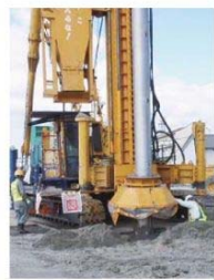
サンドコンパクションパイル打設状況 (静的砂杭締固め工法)
