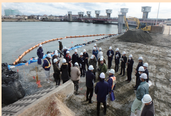
現地調査の状況
