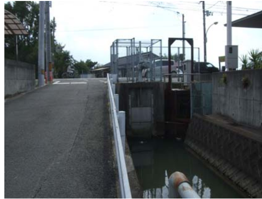
水神社樋門・ポンプ場
