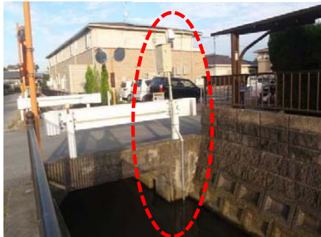
熊本地震による地盤沈下の状況(熊本県益城町周辺)
