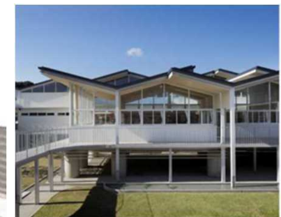
高床化による浸水対策 4
