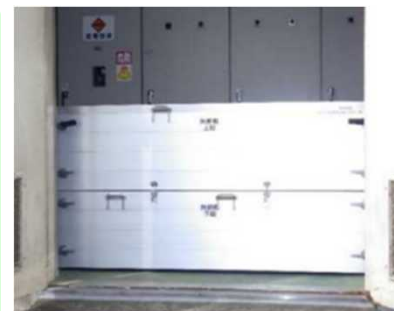
止水壁の設置
