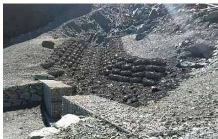
谷止工及び流路工
