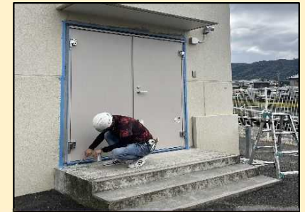
③ ポンプ場の耐水化（加茂地区）
