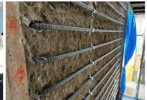
鉄筋組立状況
