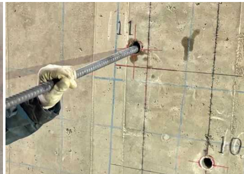
鉄筋挿入状況
