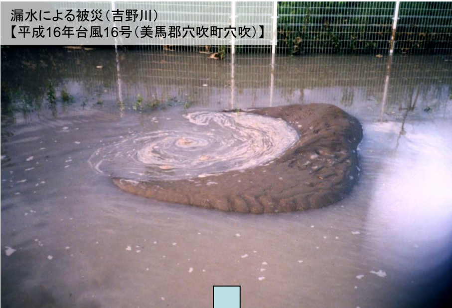
水防工法(釜段工)実施後
