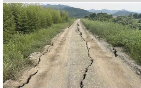
ひろとがわ ひろとがわ 広渡川水系広渡川の堤防天端の亀裂 にちなんし (宮崎県日南市)
