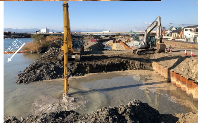
旧吉野川の河道掘削等(中喜来箇所)
