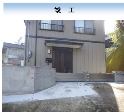
周囲堤及び止水ゲート (半田箇所の例)
