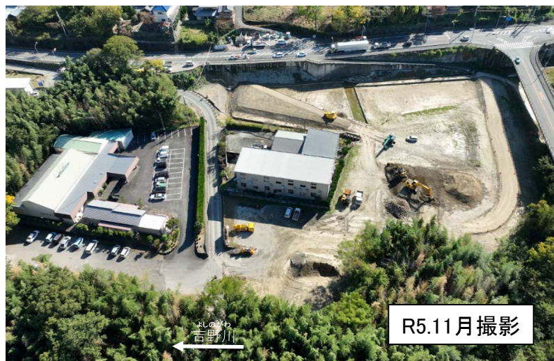
整備状況 (半田箇所の例)
