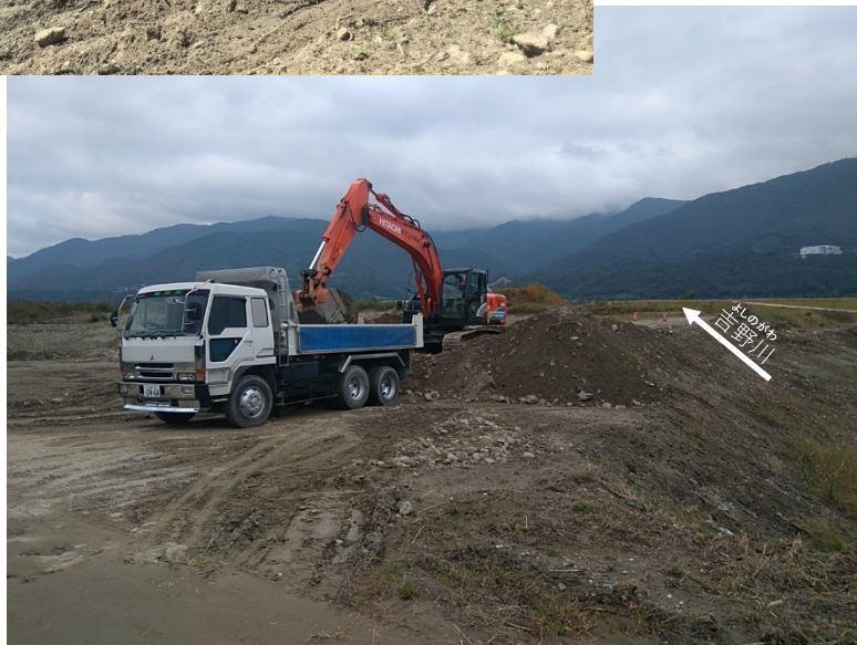
吉野川の河道掘削等(沼田箇所)
