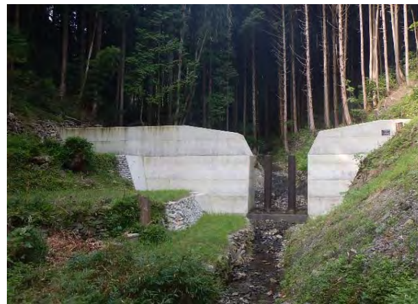
森林の維持造成に必要な治山事業 (流木捕捉式治山ダム: 吉野川市)
