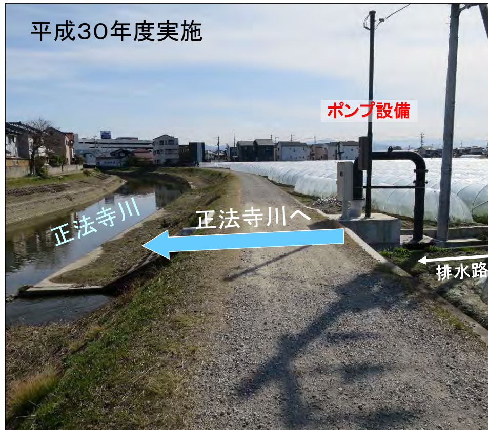
奥野排水ポンプ設置状況 (フラップゲート閉時に作動)
