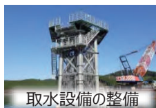
取水設備の整備
