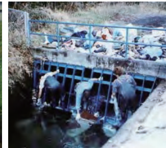
除塵機への廃棄物流入
