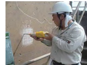
老朽化した施設の機能診断
