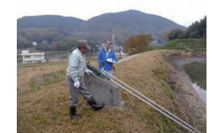
ため池の現地パトロール
