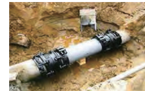
漏水防止のための整備
