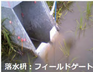
流出を抑制する排水堰板の例
