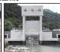
津波・高潮対策としての水門整備
