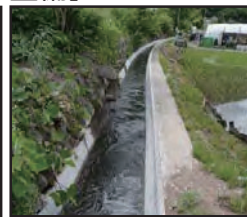
老朽化した用水路の整備・更新
