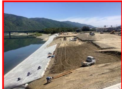
堤防整備(加茂第二地区)
