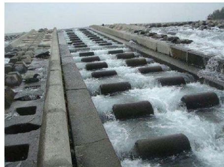
柿原堰の魚道
