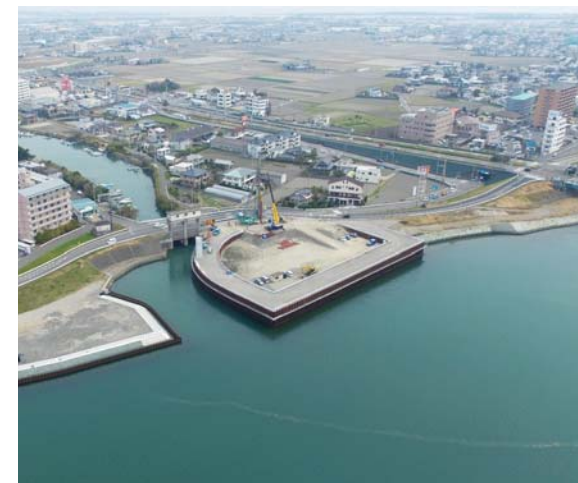
榎瀬川樋門改築
