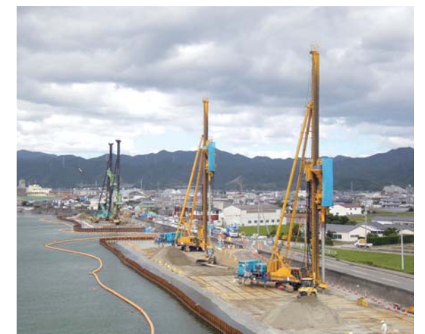
堤防液状化対策
