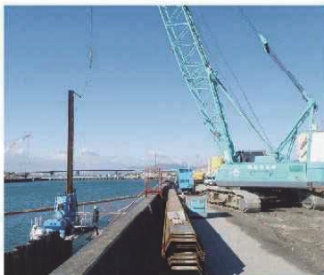
鋼矢板打設状況(油圧圧入工法)
