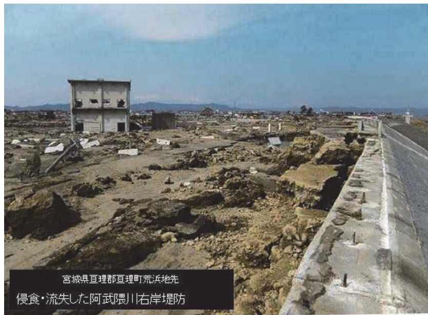
図－4.3.1 津波の猛威により侵食・流失した阿武隈川の河口部堤防 国土交通省東北地方整備局仙台河川国道事務所 HP より
