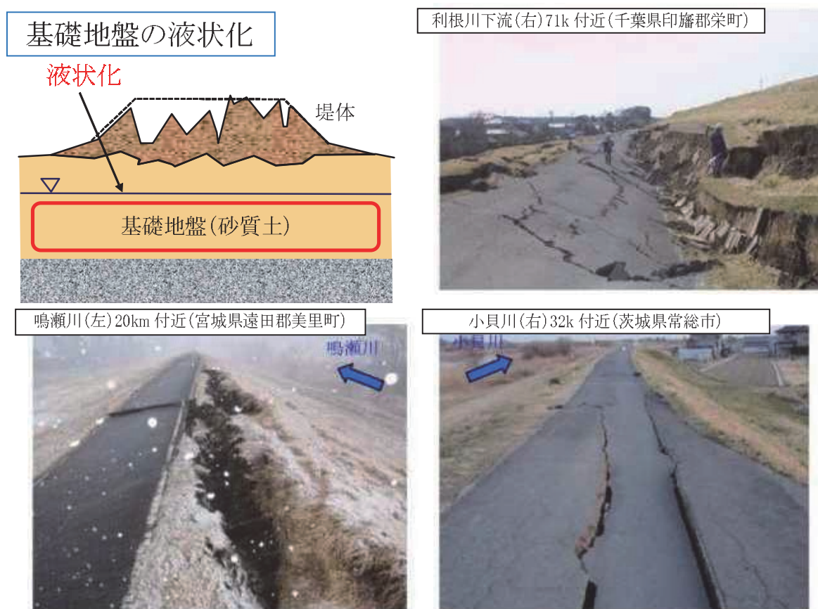
図－6.1.1 東日本大震災における液状化による堤防の被災事例
