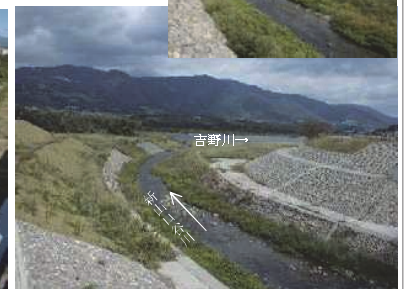
施工3年後(平成27年)
