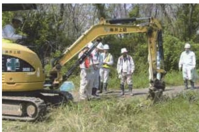
H26.4 工事影響範囲からの移植
