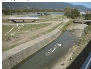
施工前(平成23年)
