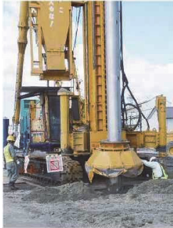
サンドコンパクションパイル打設状況 (静的砂杭締固め工法)
