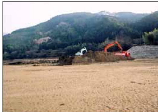
堆砂除去の状況（柳瀬ダム）
