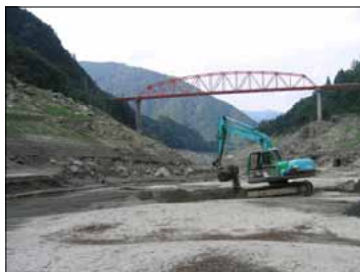
底泥除去（早明浦ダム）
