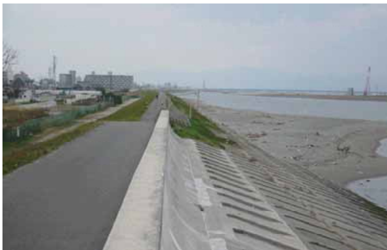
現状の堤防写真
