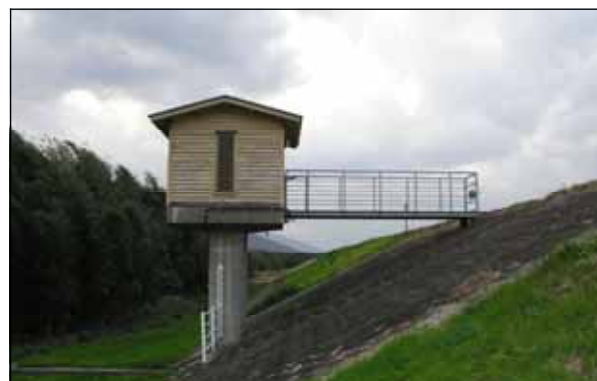
景観に配慮した排水門（樋門）の事例 吉野川左岸河口より37km付近
