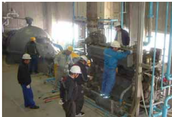
排水ポンプ場（排水機場）の点検
