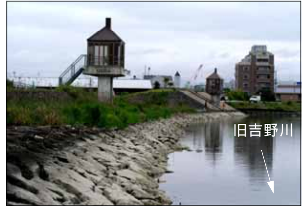
景観に配慮した排水門（樋門）の整備事例 旧吉野川右岸河口より4km付近
