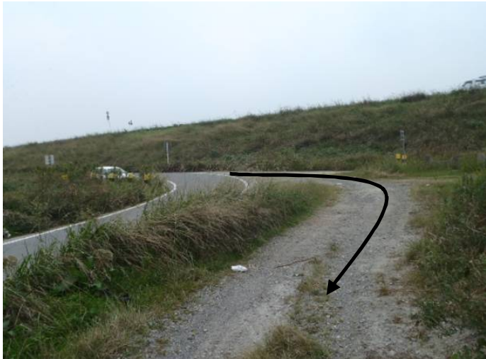
入口（高瀬橋北詰）の状況
