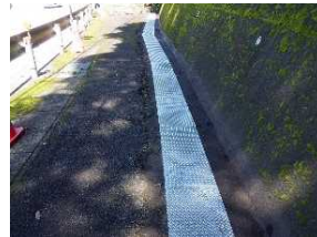
施工後（側溝蓋設置）
