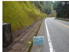
施工後（側溝蓋設置）
