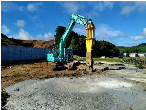
施工状況(中層混合処理)
