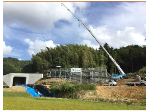
施工状況(カルバート工)
