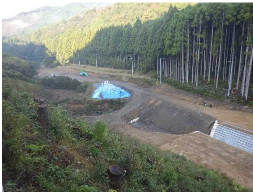
護岸工 着工前
