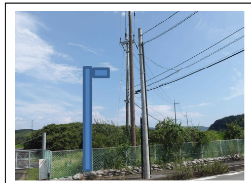
施工前(阿南相生線交差点)
