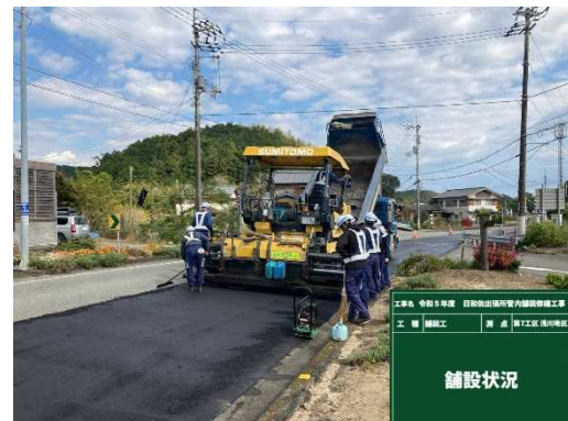
舗装張り替え状況
