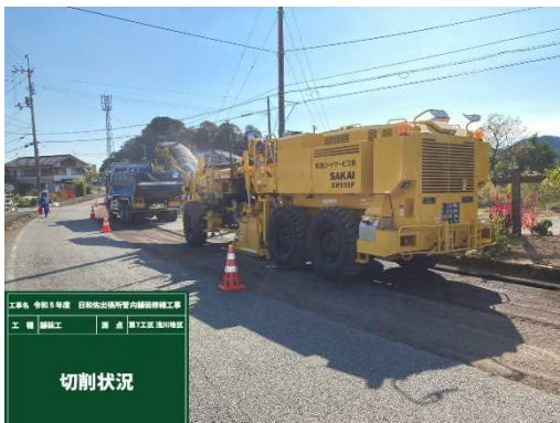
路面切削状況
