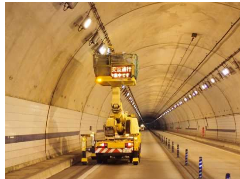
トンネル照明の修繕
