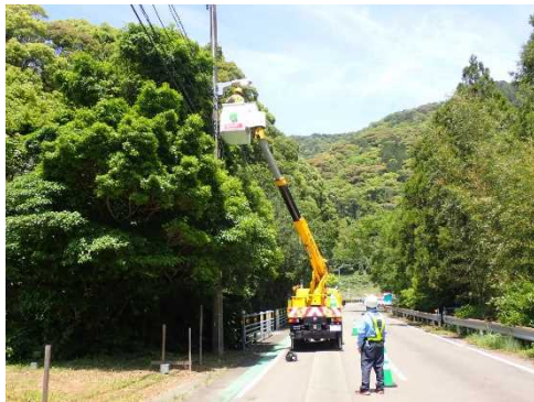
道路照明のLED更新
