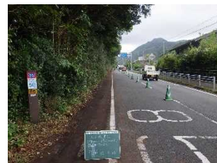
施工後（除草・堆積物除去）
