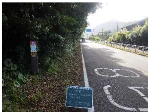
施工前（除草・堆積物除去）
