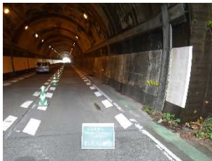
施工前（壁面清掃）
