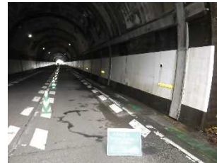
施工後（壁面清掃）
