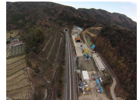
写真2: 大坂トンネル工事状況 (H26.12)
