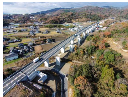
写真1: 吹田高架橋状況 (H26.12)
