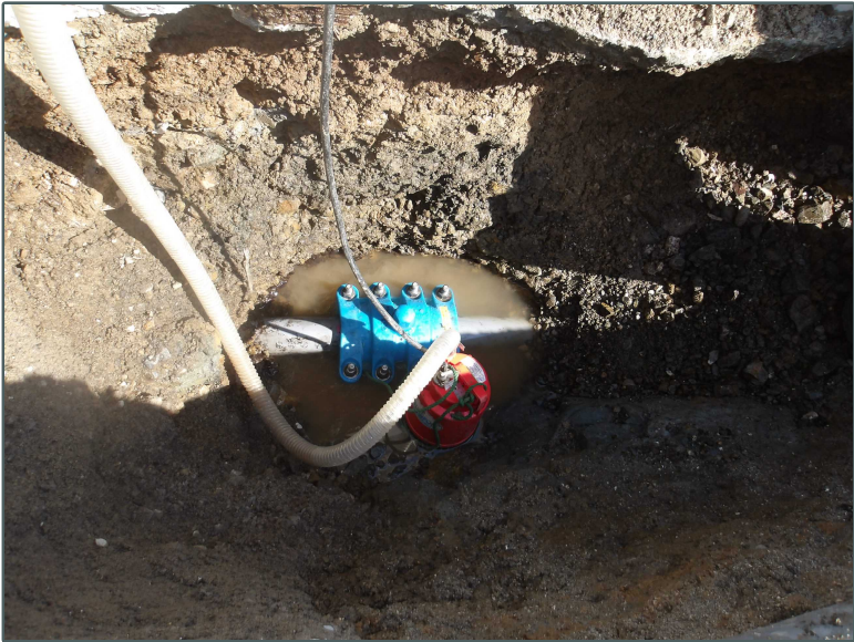
対策状況 (開削後、漏水箇所へのプロテクター(覆い)を設置)
