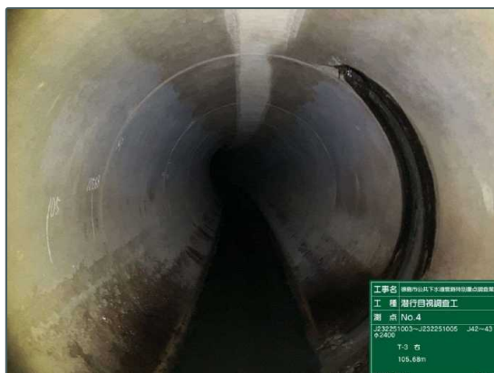
潜行による目視点検状況
