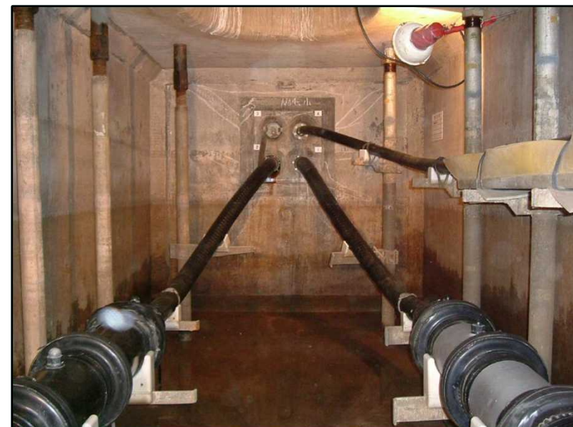
マンホール内の目視点検状況
