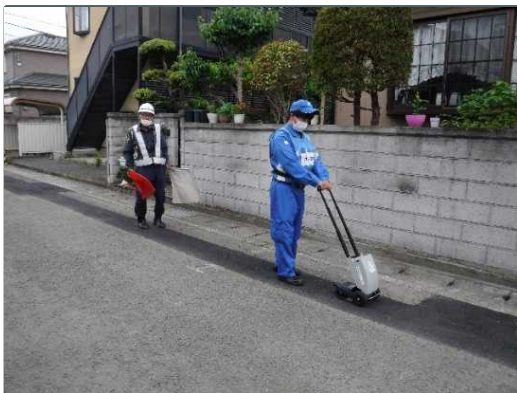
ガス検知器による点検状況
