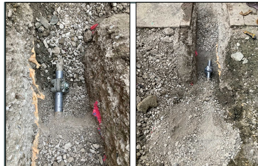
対策状況 （開削後、ガス漏れ箇所にサドル（覆い）を設置）
