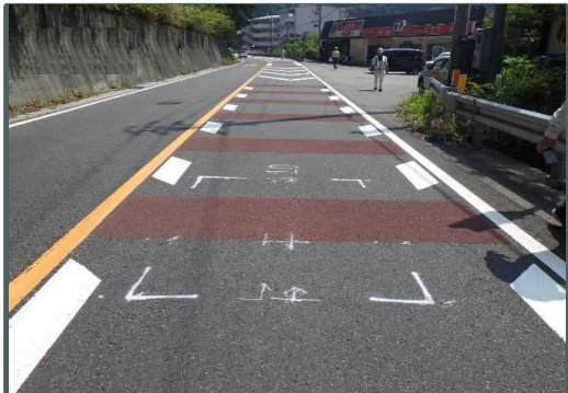
開削前 (レーダによる空洞可能性確認箇所)
