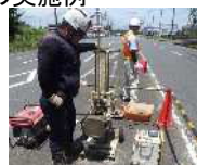
(貫入試験による調査)
