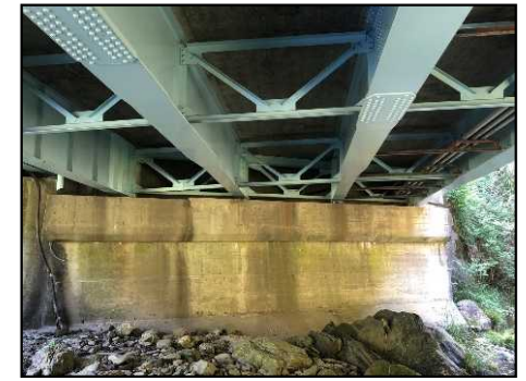
主桁あて板補修:施工後
