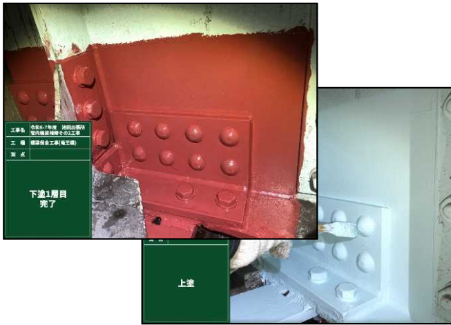
主桁あて板:部分塗装施工状況
