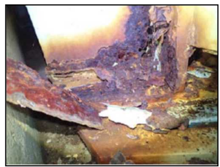
主桁端部腐食:施工前
