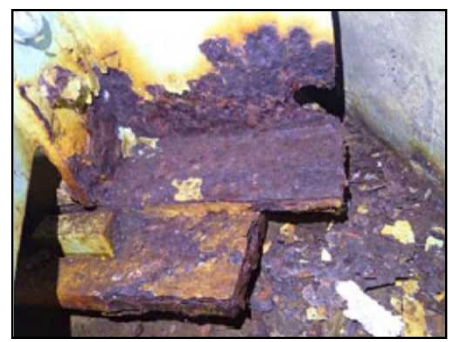
主桁端部腐食:施工前
