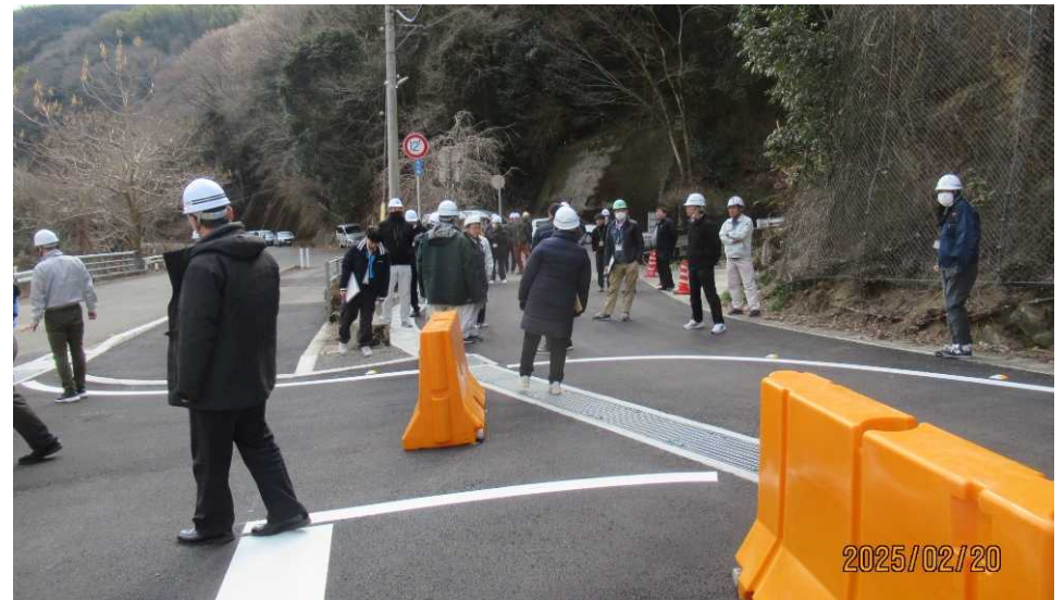
現場実習（北谷橋）
