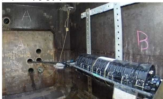
マンホール内写真
