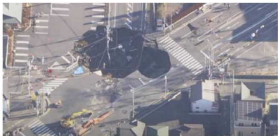
下水道等に起因する大規模な道路陥没事故を踏まえた対策検討委員会(第1回)資料抜粋
