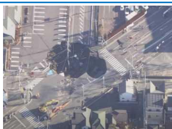
1月31日時点の事故現場の状況
