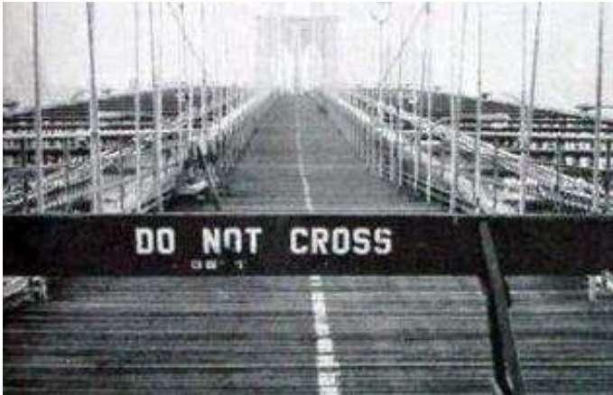
ケーブル切断事故後、通行止めになったブルックリン橋の歩道 (「高速道路と自動車」1981年11月から引用)
