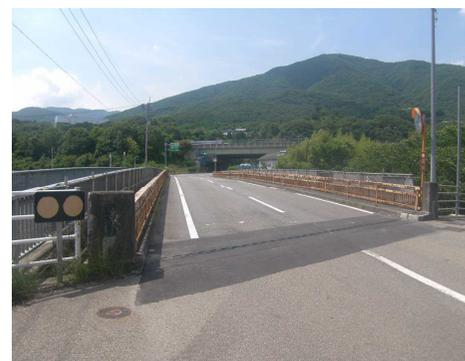
【概要】 橋長50.7m 建設年:1984年 橋種:鋼溶接I桁橋(合成)
