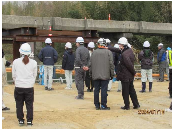
現場実習（大野島橋）
