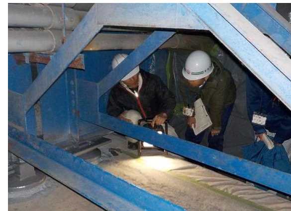
支承防錆工の施工状況見学
