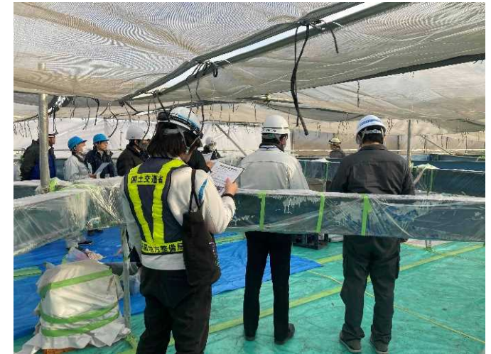
現場実習（阿波麻植大橋）
